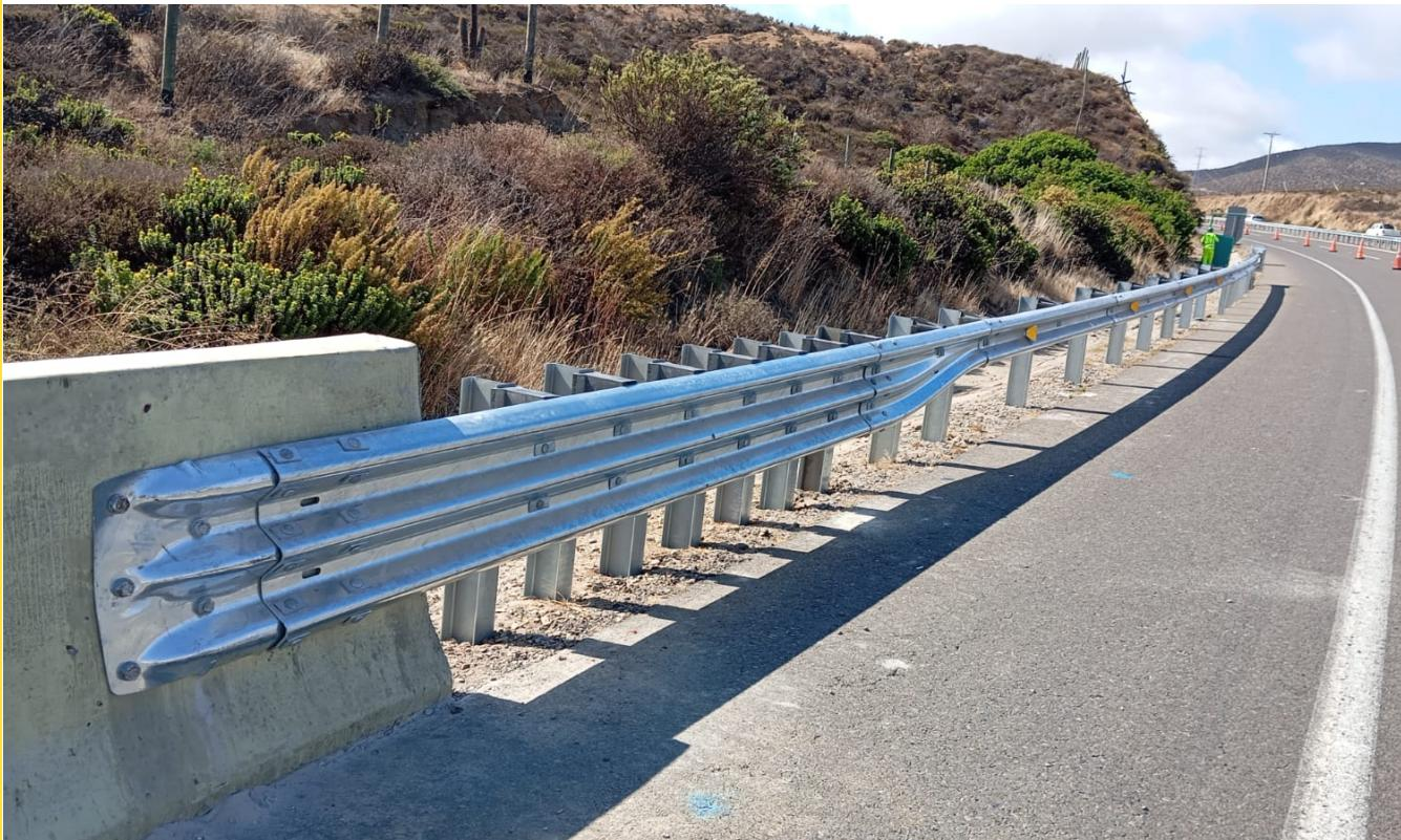
**TTV** es una transición ensayada y aprobada según norma MASH TL3, para conectar terminales certificados a muros, columnas, barreras de hormigón de extrema rigidez o barreras estructurales de puentes, ya sean metálicas o de hormigón.
