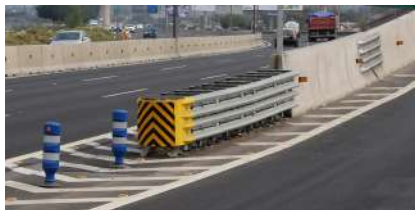
Salida Costanera Norte - Autopista Central, Santiago, Chile
